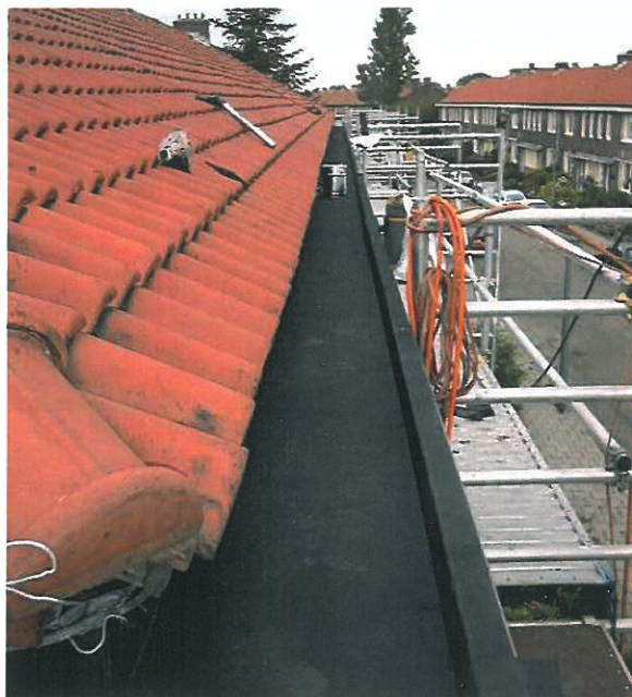
Täta rännor med Resistit E SK, ren och prydlig inklädnad.
